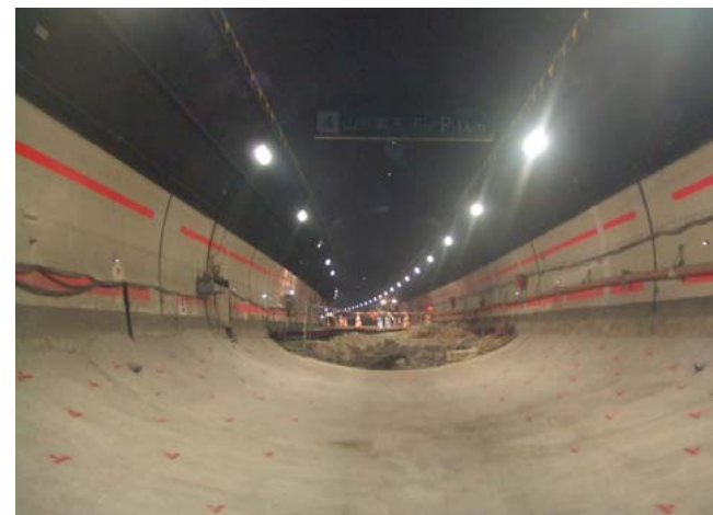
インバート設置による対策状況
