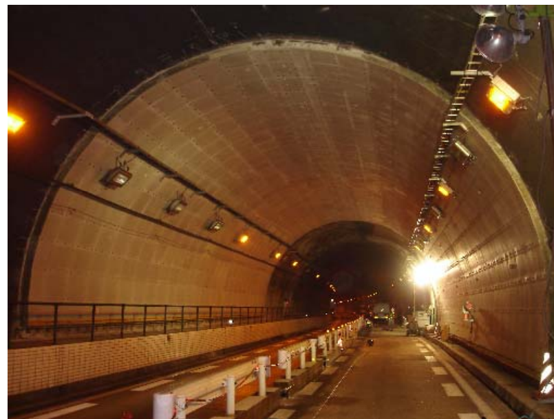
内面補強対策工による対策状況
