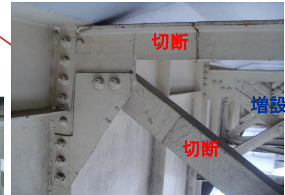
21~25年後 : 対傾構増設と既設対傾構切断
