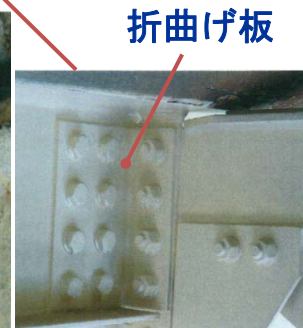
19年後 : ストップホール・折曲げ板取付け
