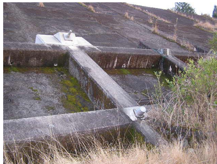
アンカー増打ちなど補強アンカー
