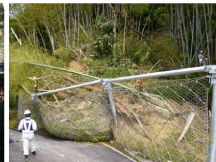
ワイヤーネットを設置した事例
