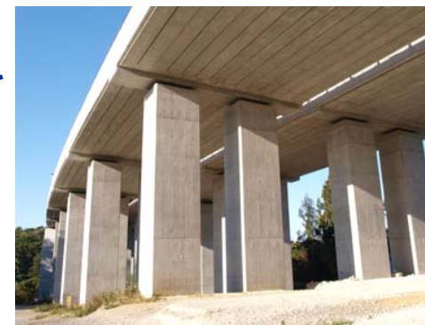
34年後 : 架替後のプレテンPCホロー桁
