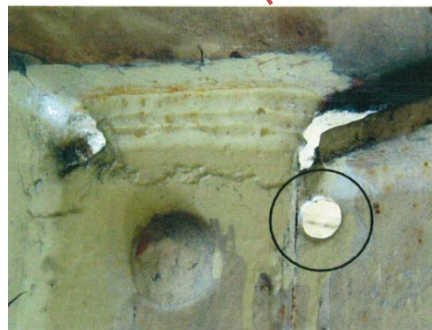
19年後 : ストップホール・折曲げ板取付け
